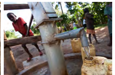
Suministro de agua y saneamiento
